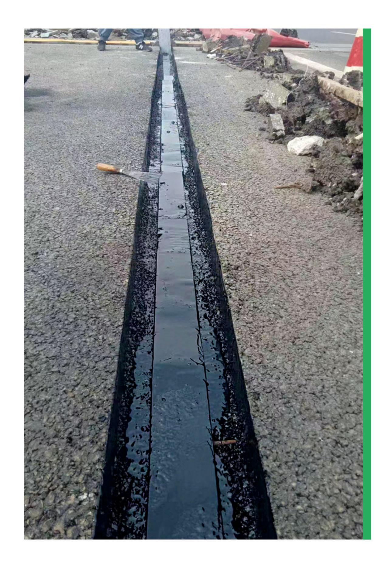
无缝伸缩缝胶是一种填充沥青的桥梁伸缩缝。其基本方法是用一种特殊的高弹性沥青混合料代替桥接缝上方狭窄范围的桥面铺装。这种高弹性的特殊沥青和石料混合料可以吸收桥面因温度和交通荷载而产生的位移,并确保表层不会开裂和损坏。
