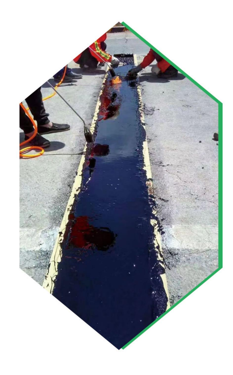
**施工方便灵活**:一支技术精湛的施工队伍(8-10人)每天可延长 30米伸缩缝,可进行半幅施工,不阻塞交通。
